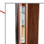
nastaviteľný protiplech zámku
